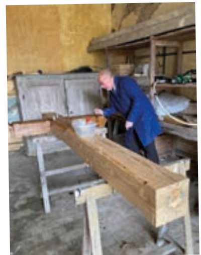
Remise en état du calvaire proche des commerces et de celui de la route du Calvaire / RD47.
